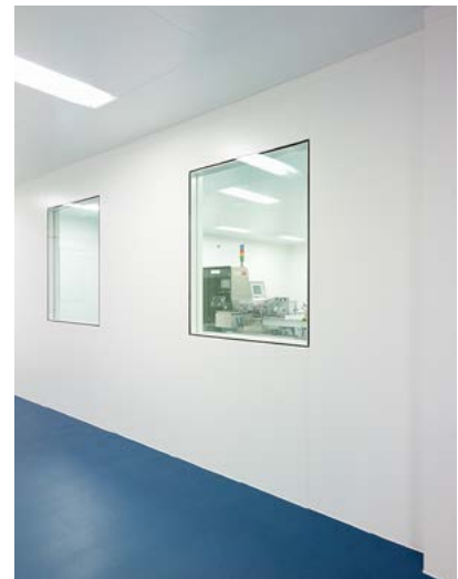
GMP Wandsystem mit Fensterausschnitt
