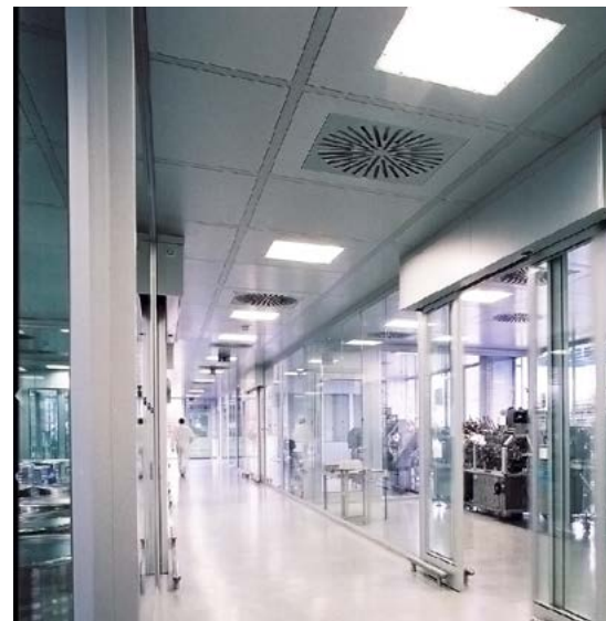
Beispiel für das T-Raster Deckensystem mit flexibler Raumaufteilung
